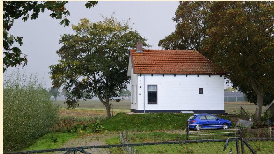
Sluiswachterswoning, gelegen bij een kruising van waterwegen. Dit zeldzaam bouwtype is nu in gebruik als woonhuis.
