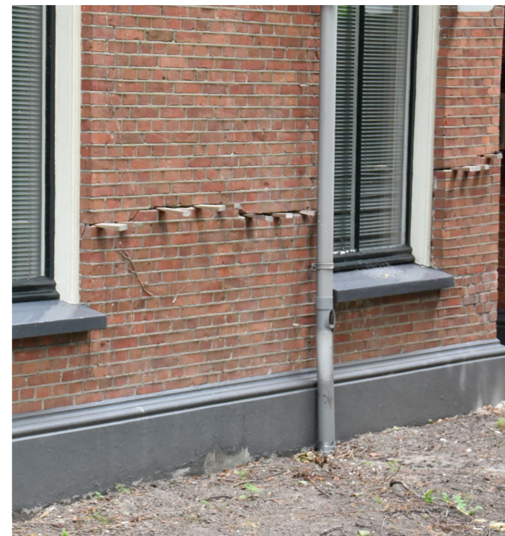
Plaatselijk voegwerkherstel is vergunningvrij.
